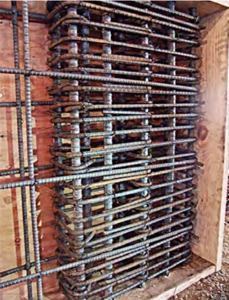
Fig. 3 & 3a: Las diferentes configuraciones de refuerzo requieren diferentes consistencias de la mezcla.
