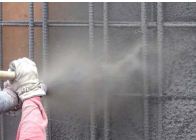
Fig. 1: Los diseños modernos de boquillas difuminan y aceleran la mezcla en miles de partículas individuales que se mueven alta velocidad en forma de una corriente saliendo de la boquilla.
