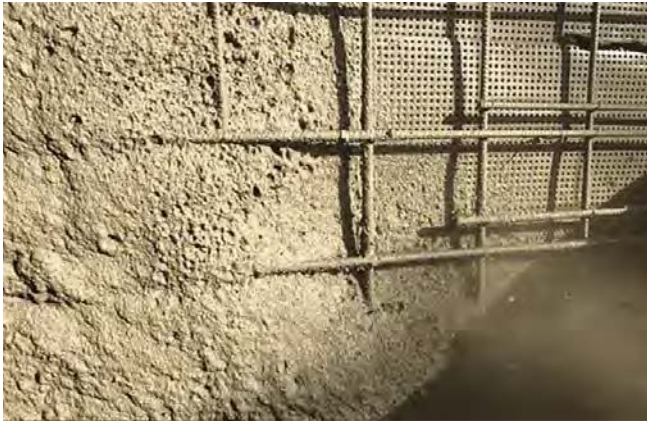
Fig. 7: el revenimiento ideal permite que los agregados entrantes se incrusten profundamente dentro del mortero en lugar de permanecer en la superficie.
