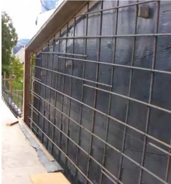
Fig. 3 & 3a: Las diferentes configuraciones de refuerzo requieren diferentes consistencias de la mezcla.
